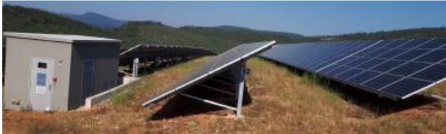
Figure 4 : Exemple de structure fixe d'une centrale PV
